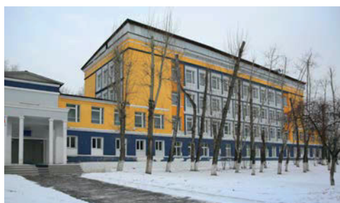
ЭГ № 983 (ул. Иркутская, 2)
