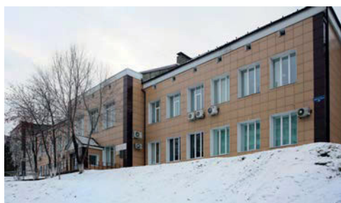
ЭГ № 987, ЭГ № 3343, ЭГ № 3349 (ул. Охраны Труда, 20)
